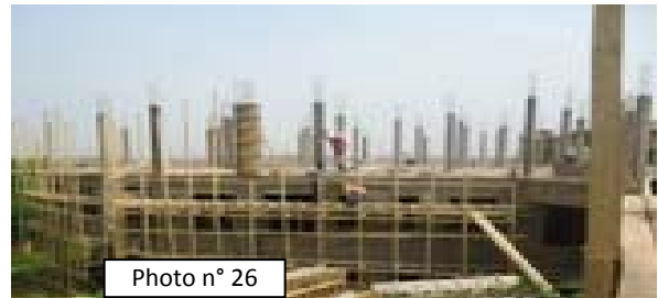
Construction d'une bibliothèque à l'ENSTP de Yaoundé (17/12/12) : Coulage des poteaux du 2° niveau en cours
