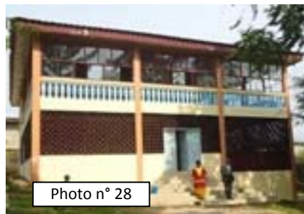
Réhabilitation du restaurant du Jardin Zoologique de Mvog Betsi (18/12/12) : Peinture refaite, carreaux renouvelés, faux plafond remplacé
