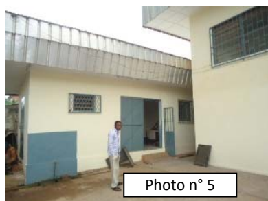
Réhabilitation CSPLI (07/08/12) : Peinture renouvelée, Chéneaux recouverts d'un isolant, Caniveaux en cours.
