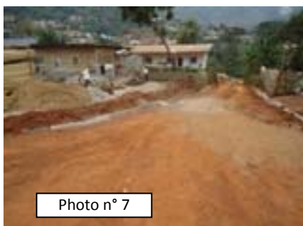
Projet d'aménagement de forte pentes (descente tabernacle du Golfe) dans les quartiers Mbankolo et Obobogo à Yaoundé (17/12/12) : Dessus des caniveaux non homogène à Mbankolo, Coulage s'effritant par endroit sur le caniveau
