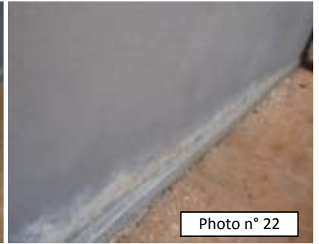
EM ESSOS 2 "A" : Construction d'un Bloc Maternel (19/12/12, 100%) : Peinture se décapant sur la plinthe et sur la fondation
