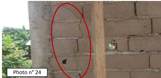
EM ESSOS MARCHÉ : Construction d'un Bloc Maternel (19/12/12, 70%) : Fissurations sur le mur externe droit
