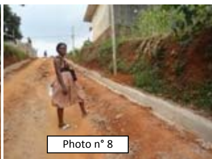
Projet d'aménagement de forte pentes (descente tabernacle du Golfe) dans les quartiers Mbankolo et Obobogo à Yaoundé (17/12/12) : Dessus des caniveaux non homogène à Mbankolo, Coulage s'effritant par endroit sur le caniveau
