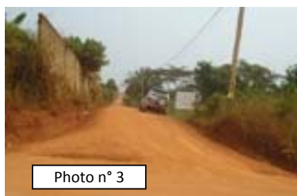
Réhabilitation de la piste première entrée après le pont-Entrée avant Elite School Carrefour Ngoume (18/12/12) : Rigoles creusées, latérite posée sur l'assiette
