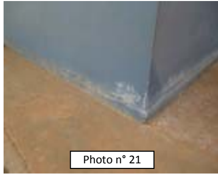
EM ESSOS 2 "A" : Construction d'un Bloc Maternel (19/12/12, 100%) : Peinture se décapant sur la plinthe et sur la fondation
